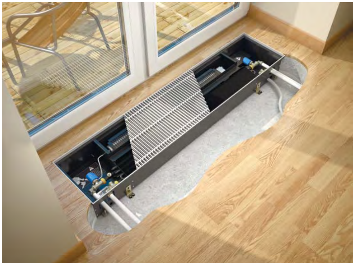
Монтаж конвектора Qtherm HK4 310.130 в четырехтрубную систему с подключением теплоносителя "справа" и холодоносителя "слева", расположение вентиляторов со стороны окна.
